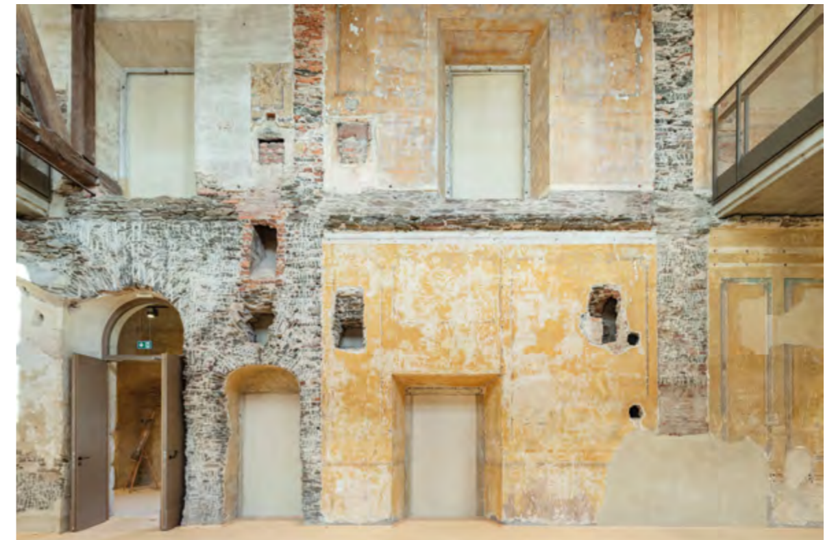
Östliche Wand im Emporensaal
