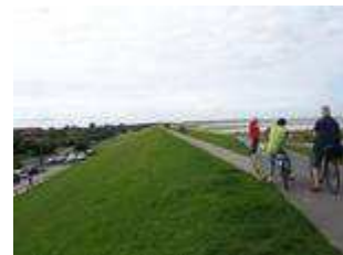
Die Landseite eines Deiches
