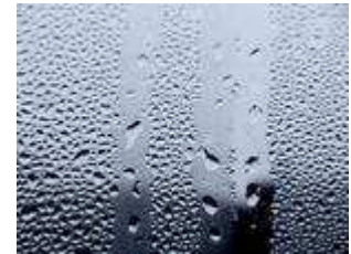
Beschlagene Scheiben weisen auf hohe Luftfeuchte hin
