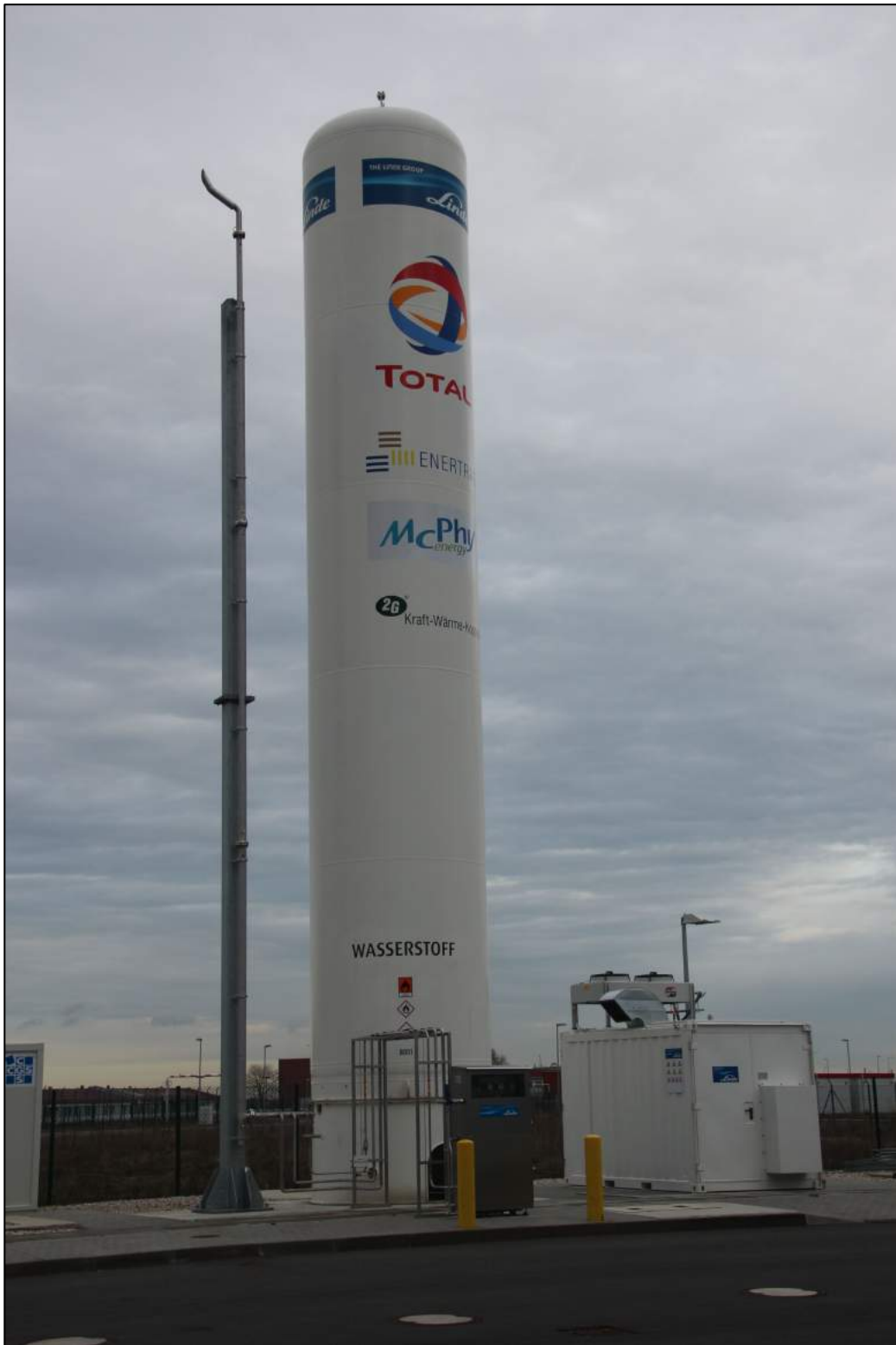
Abbildung C4.04 Wasserstoffspeicher bei der Tankstelle
