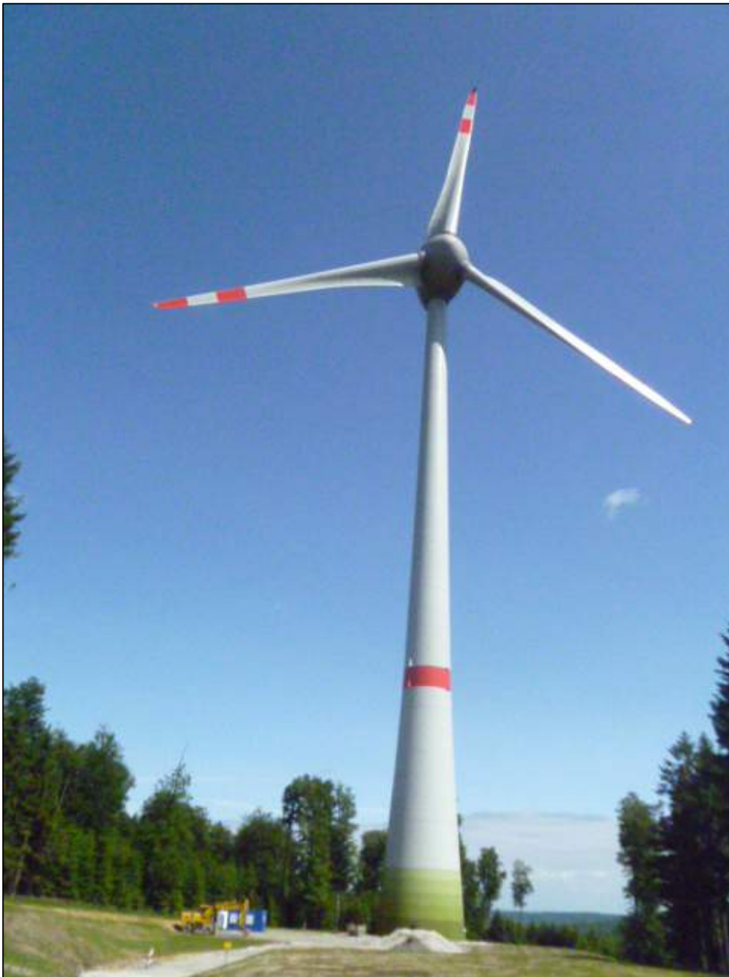
Abbildung C3.05 Moderne Windkraftanlage mit 7,5 MW Leistung
