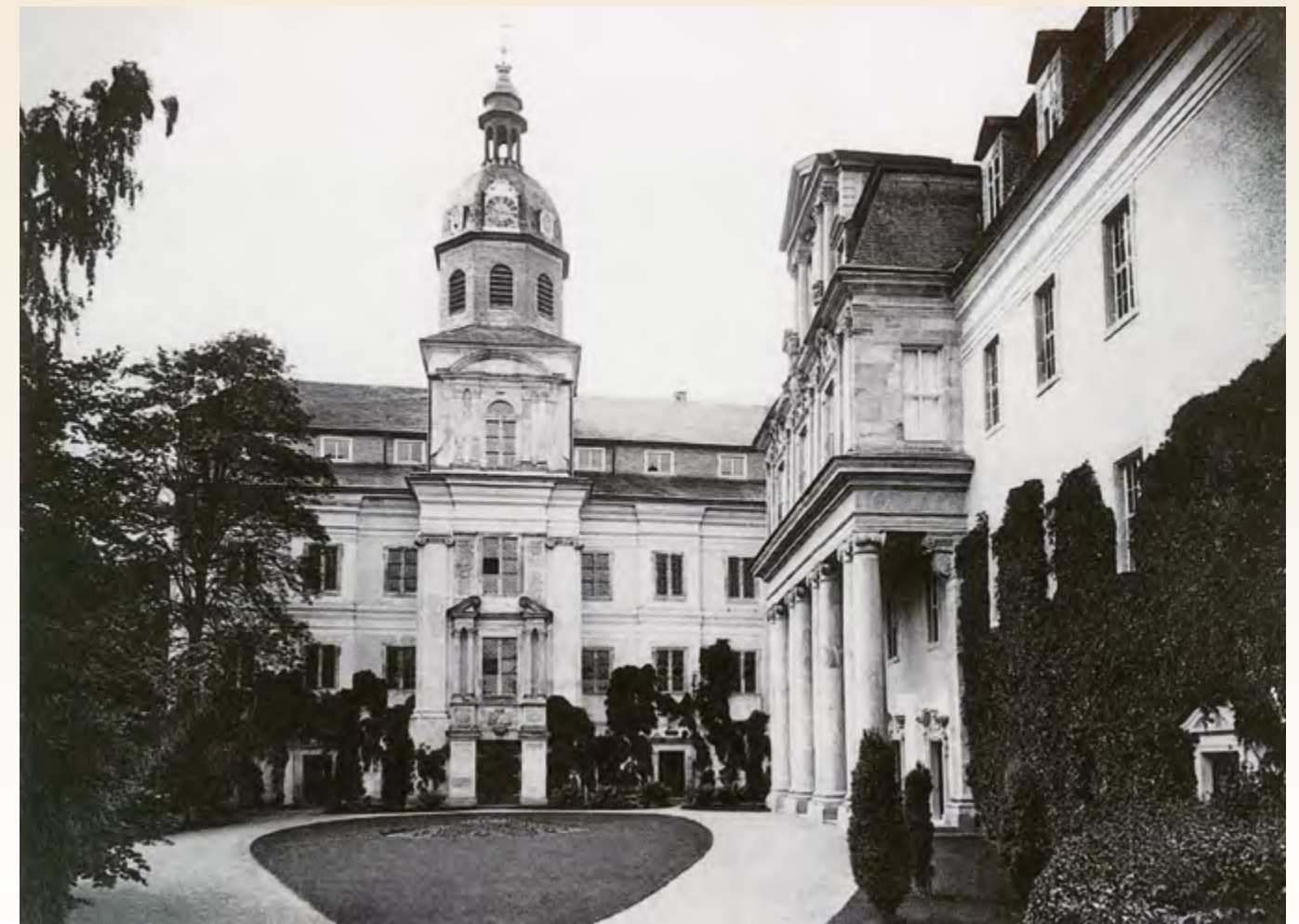
Schloss Schwarzburg, Hauptgebäude (rechts) mit ehemaligem Kirchflügel und Turm, historische Aufnahme
