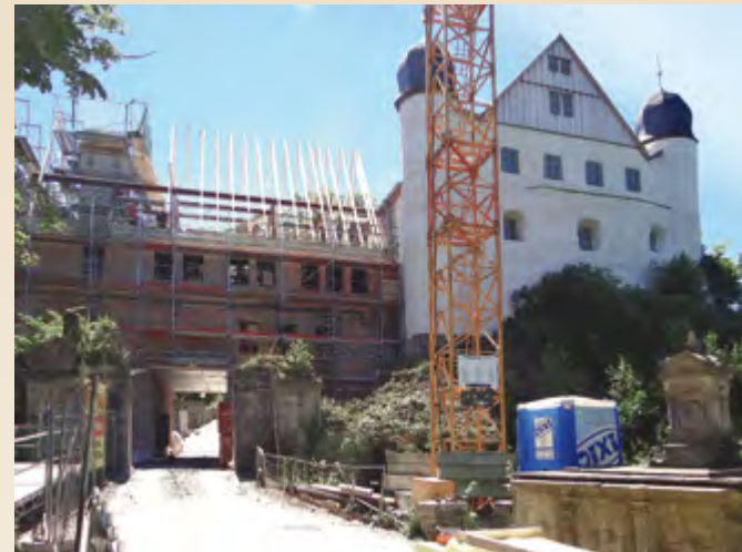
Schloss Schwarzburg, Torhausbaustelle, Richtfest am 23. Juni 2016
