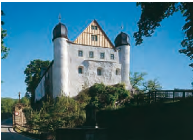
Schloss Schwarzburg, Zeughaus nach der Sanierung 2011
