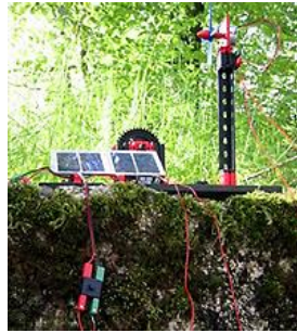
Abb. 2: Das Solarkraftwerk in Betrieb im Schulgarten
