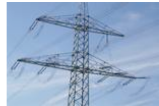
Der Mast einer Freileitung - hier knistert es meist am stärksten
